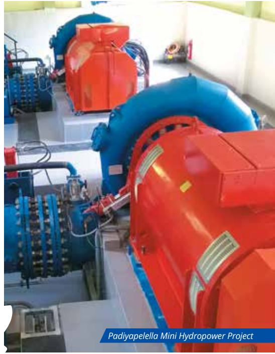
Padiyapelella Mini Hydropower Project
